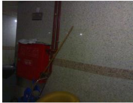
صورة رقم (4-15) تبين أماكن توزيع صندوق خراطيم المياه 3/4" في الممرات والطوابق المتكررة، والبهو على اليسار، (الباحث).
